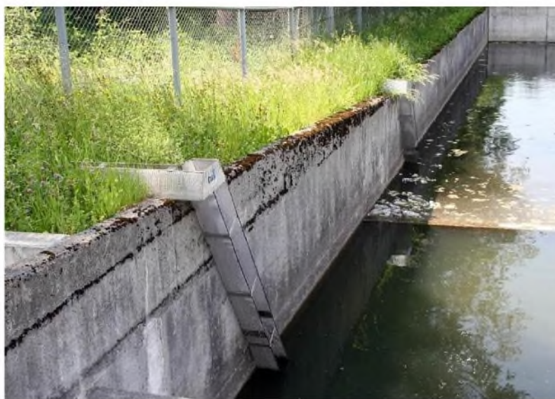
Figura 6 SCALE DI RISALITA PER ANFIBI
