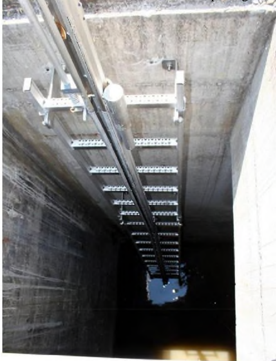
Figura 3 SCALE SENZA PARASCHIENA
